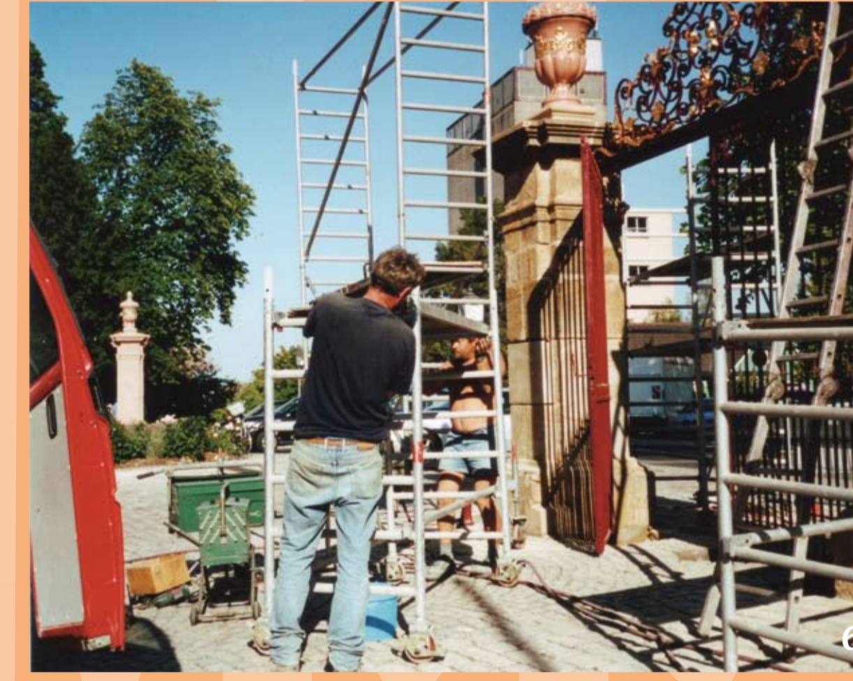
Das barocke Portal am Schloßplatz wird restauriert
